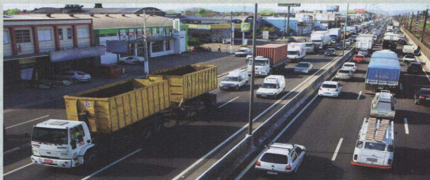
Trecho da BR-116 em Novo Hamburgo, 2013.
