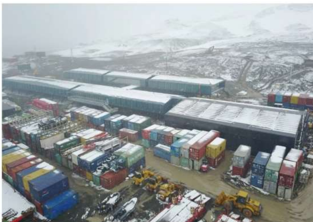
Obras de reconstrução de base na Antártica — Foto: Marinha do Brasil/Divulgação
